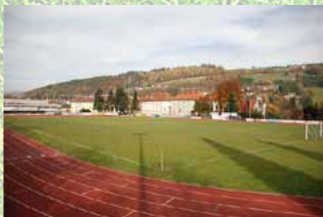
Alpenstadion vor der Sanierung
